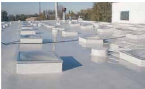
Дымовые люки КЛАПАР® по конструктивному исполнению изготавливаются двух типов:
